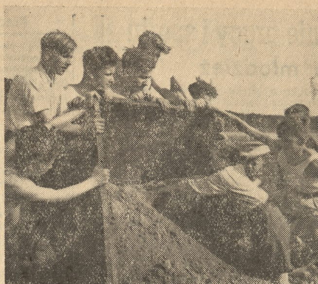
Fot. Tadeusz Pasikowski Harczerze z Ognia nr 3 w Skokach, pomagają dziełnie w pracach związanych z budową kąpieliska nad jeziorem Maciejak.
