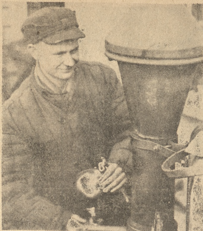
CAF — fot. Zawidzki Załoga Państwowego Ośrodka Maszynowego w Kiedzku w woj. poznańskim zobowiązała się przygotować wszystkie maszyny do akcji wiosennej na 3 dni przed terminem. Skrócenie czasu remontu możliwe było dzięki przekroczeniu norm przez wielu pracowników POM. — Na zdjęciu: przodownik pracy, ZMP-owiec Zdzisław Kanasiak, wyrabiający średnio 150 proc. normy.
