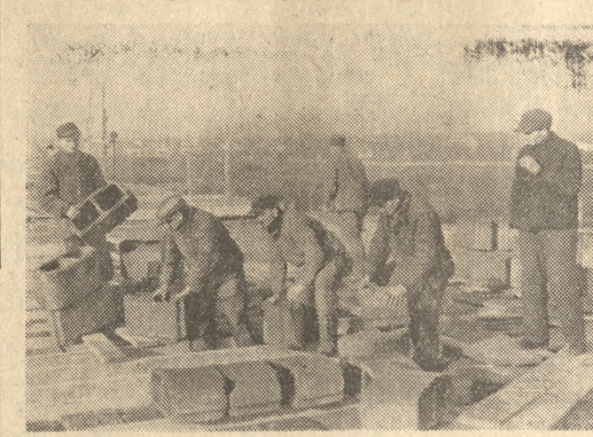
Fot. (2) K. Przychodźki — „Głos” Brygada Baraniaka układa codziennie około 150 m 2 stropów z prefabrykowanych elementów
