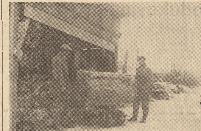
Przodujący betoniarze: Franciszek Ratajczak i Adam Bartkowiak.
