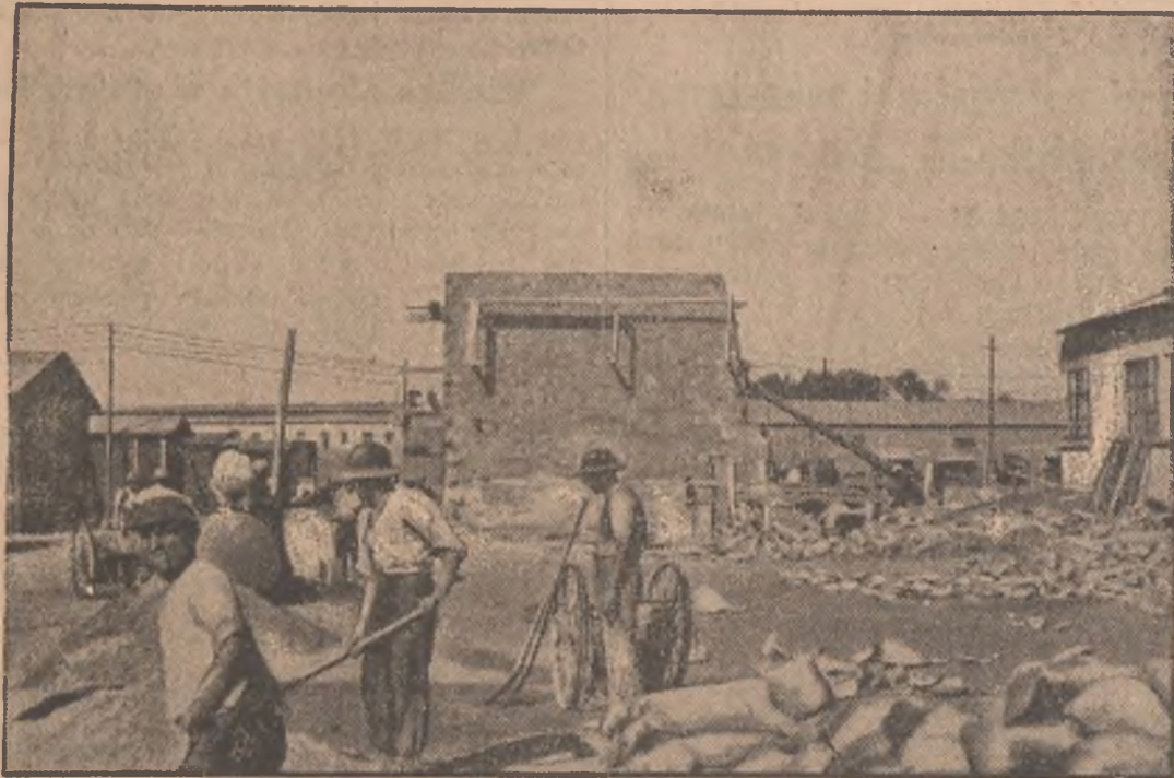
W tych dniach przystąpiły władze włoskie do budowy na szeroką skalę pomysły zakładów „Fiata” w Asmarze (Erytreja). Zakłady te mają pokrywać zapotrzebowanie kolonii włoskich w Afryce. Robotnicy przystąpili już — jak widzimy na powyższym zdjęciu — do pracy.
