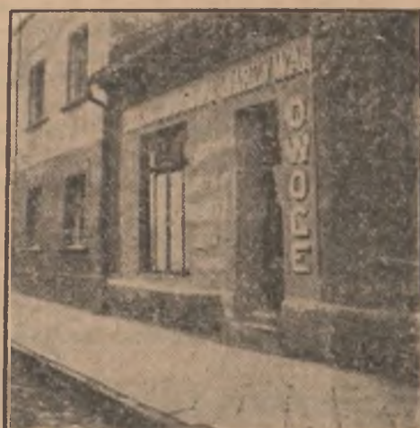
Jeden ze zdemolowanych w czasie zaburzeń składów, w którym wybite okna zastąpiono deskami.
