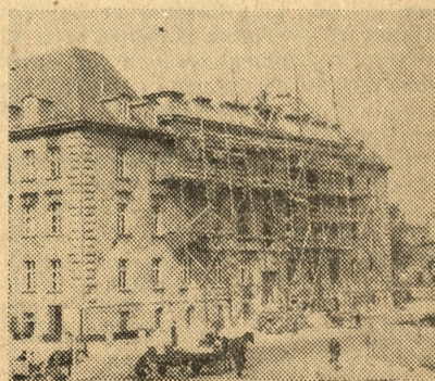
Prace przy odbudowie poznańskiej Izby Rzemieślniczej dobiegają już końca.
