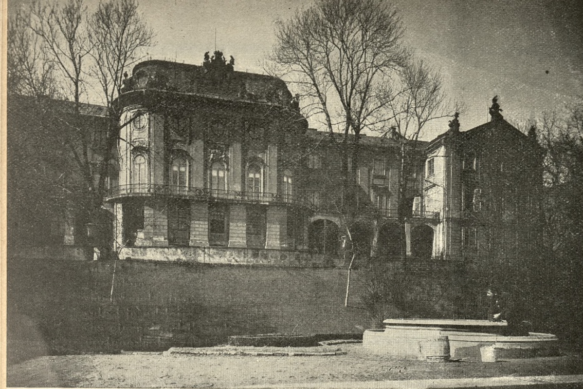
Zamek Królewski. Część elewacji od strony ogrodu.
