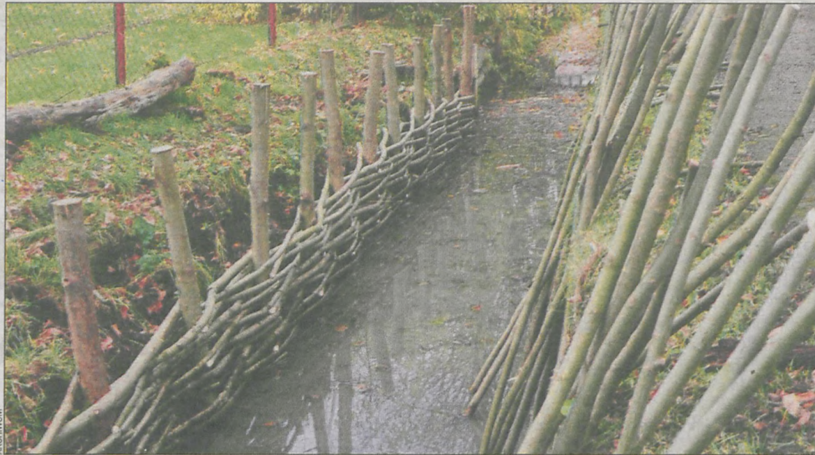
Faszyna służy do umacniania skarp
