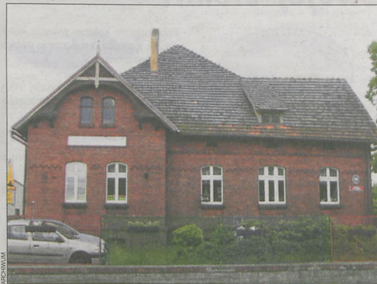
Przebudowę przejdzie przedszkole w Zdunach i Bestwinie
