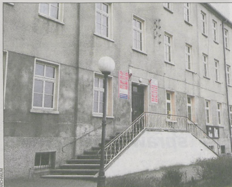
Zespół Szkół i Urząd Miejski przejdzie termomodernizację
