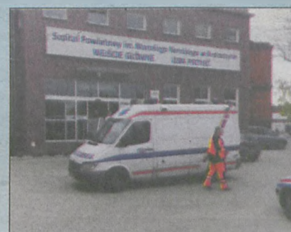
Oddane niedawno do użytku wejście główne do szpitala przy ul. Mickiewicza
