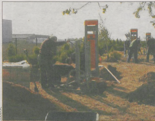
Mieszkańcy uczestniczą w budowie siłowni
