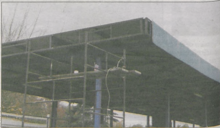
Dworzec przeszedł gruntowną modernizacją
