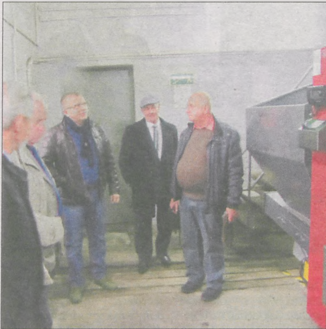
Odbiór techniczny zmodernizowanej kotłowni w szkole
