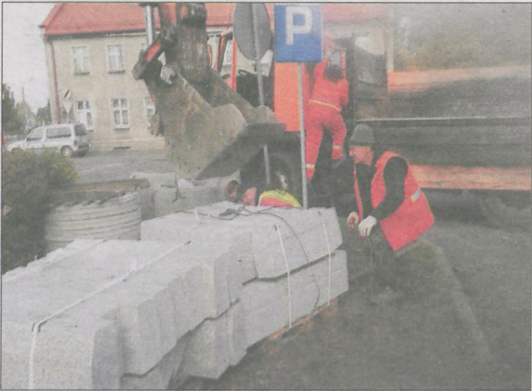
Roboty wykonuje firma z Krotoszyńska
