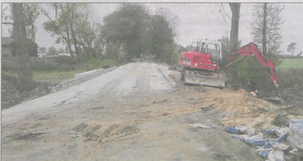
Obecnie zakładana jest nowa nawierzchnia drogi
