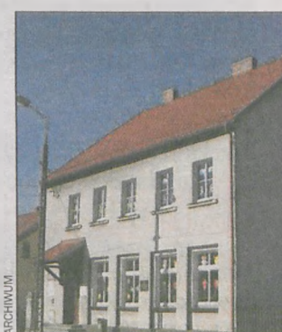
Budynek do remontu
