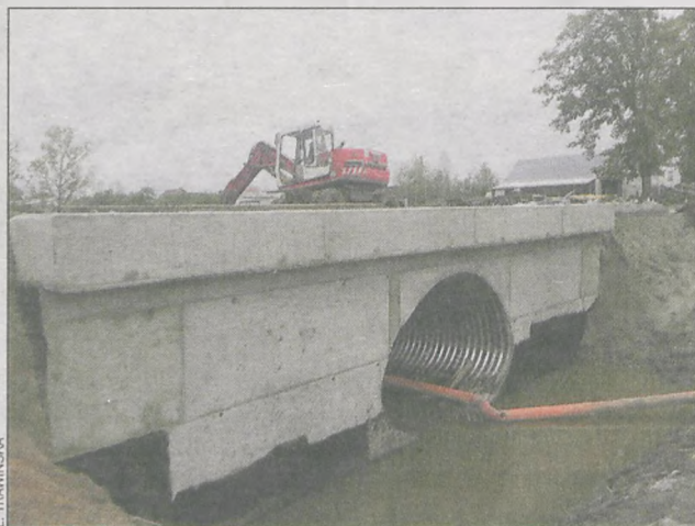
Położono już rury, ścianki i krawężniki
