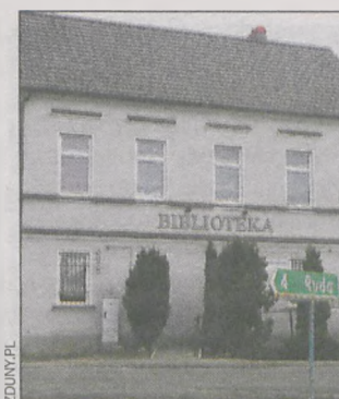
Biblioteka w Baszkowie zostanie gruntownie wyremontowana
