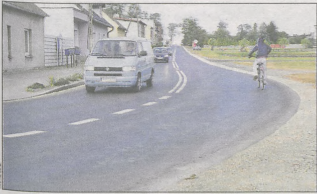
Przebudowę wykonano fachowo i w terminie
