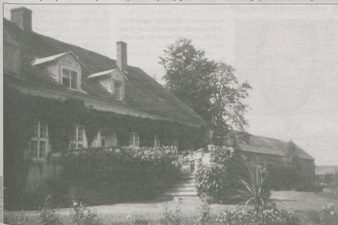
Zachodnia elewacja dworu Chelkowskich z tarasem (stan sprzed 1939)
