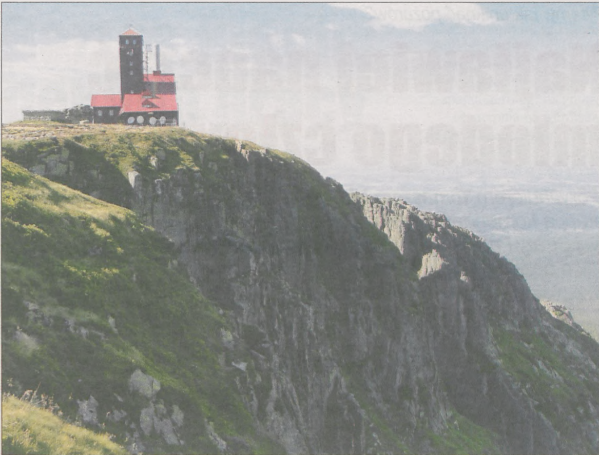
Śnieżne Kotły z charakterystycznym budynkiem stacji przekaźnikowej
