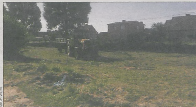
Prace już trwają
