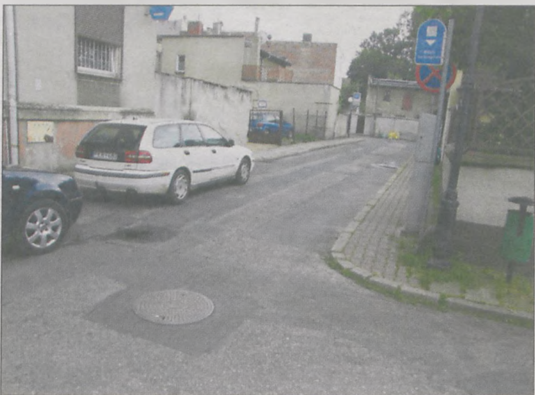
Na ul. Podgórznej brak linii poziomych
