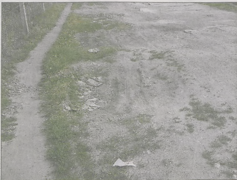
Stan odcinka jest opłakany, a mieszkańcy proszą o remont od marca
