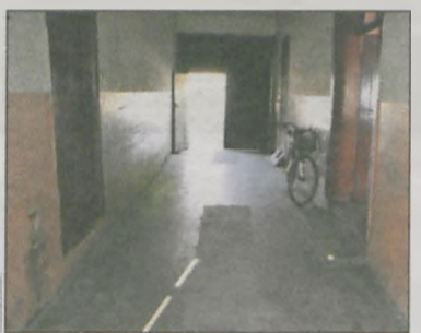
Odnowiony zostanie korytarz budynku
