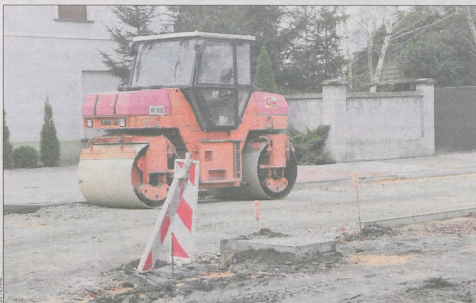
Ul. Grobla podczas przebudowy, 2014 r.
