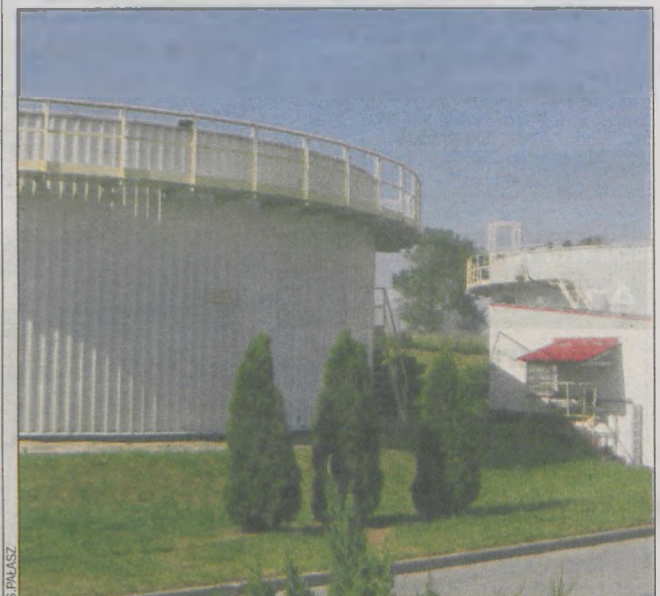
Oczyszczalnia ścieków w Zdunach
