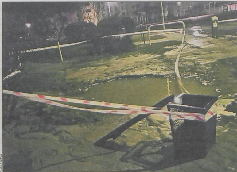
W tym miejscu pękła rura. Woda rozlała się na pobliski teren
