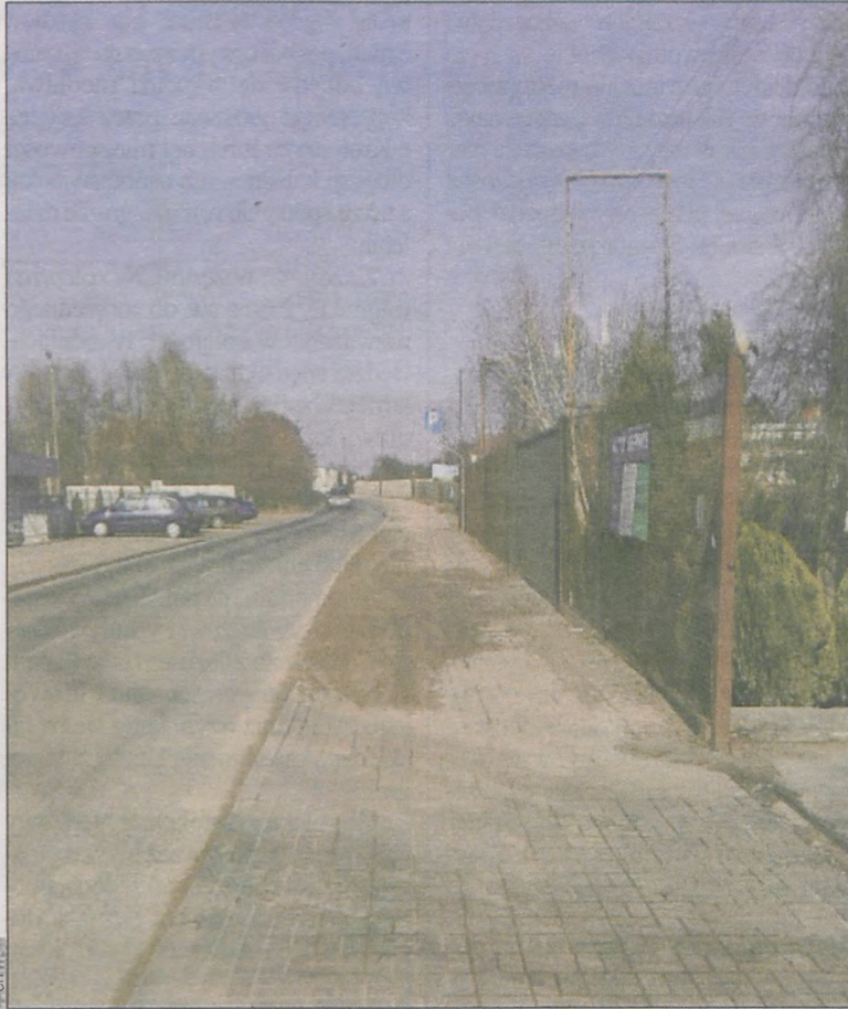
Ścieżka na ul. Magazynowej – widok od strony skrzyżowania do zakładu betoniarzkiego
