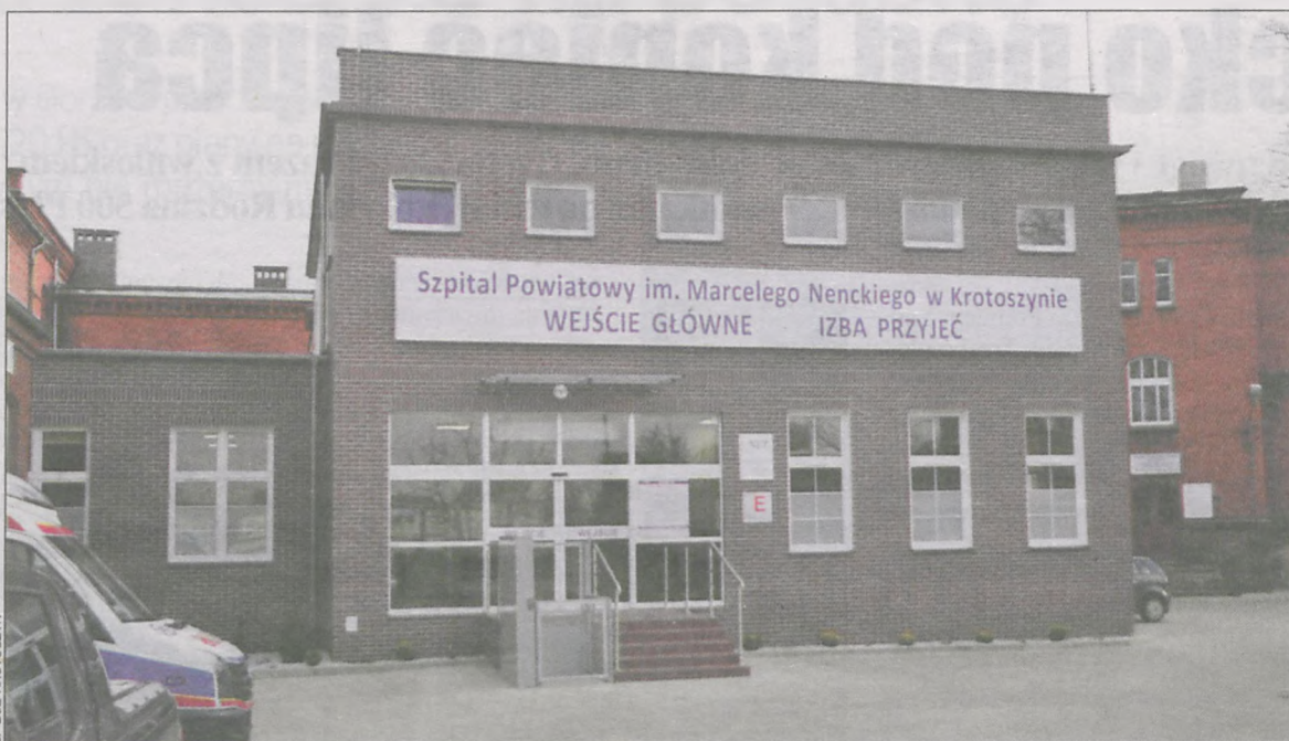
Nowe, główne wejście do szpitala
