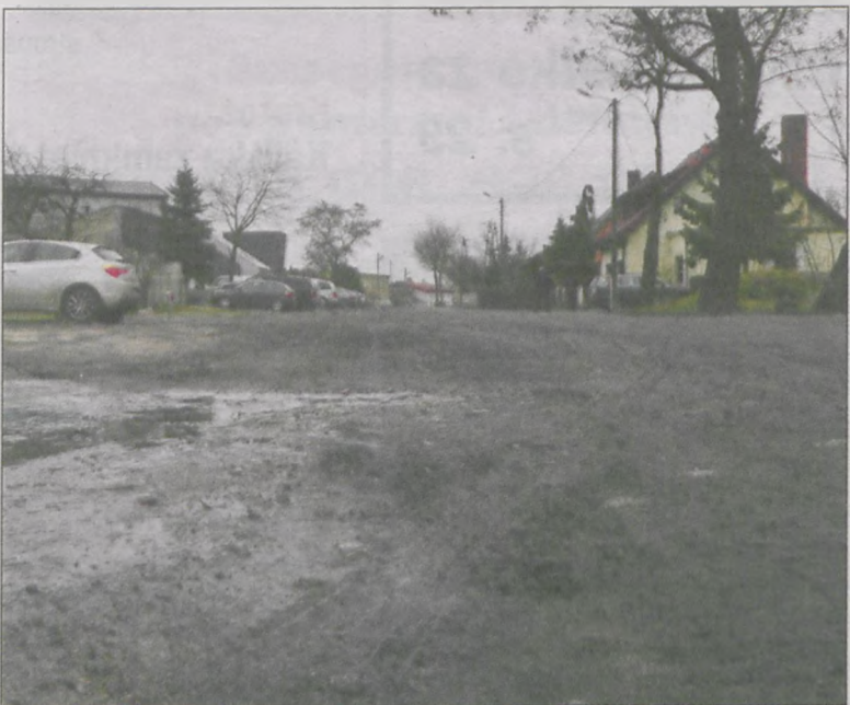
Poruszanie się tą drogą rodzi liczne zagrożenia
