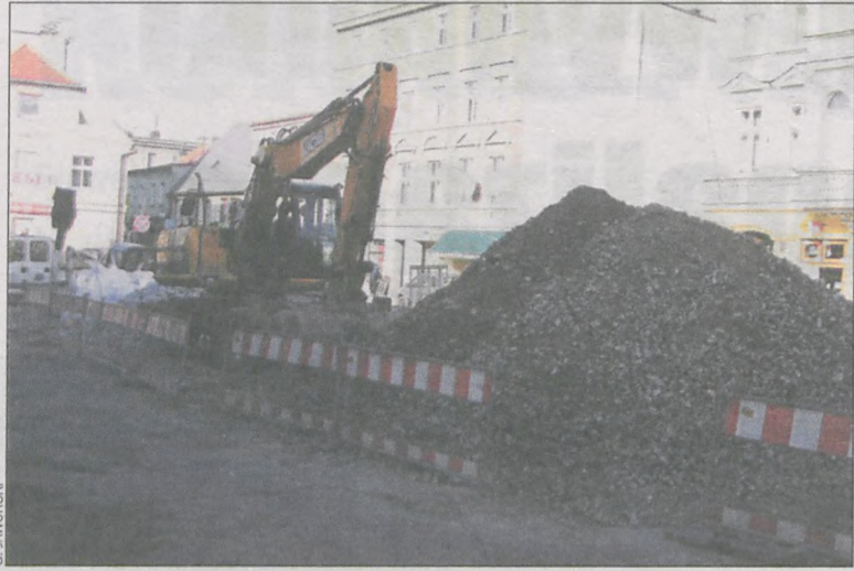
Teren jest zabezpieczony, a prace posuwają się w szybkim tempie
