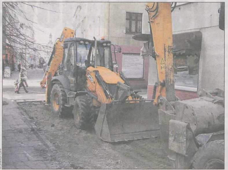
Prace na ul. Gołębiej wymagały użycia ciężkiego sprzętu
