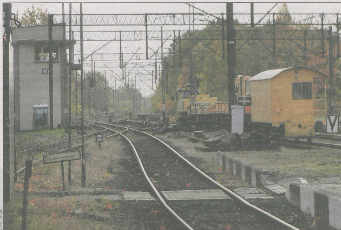
Prace na południowym wyjeździe ze stacji Krotoszyn, tuż przed wiaduktem nad ul. Kobylińską
