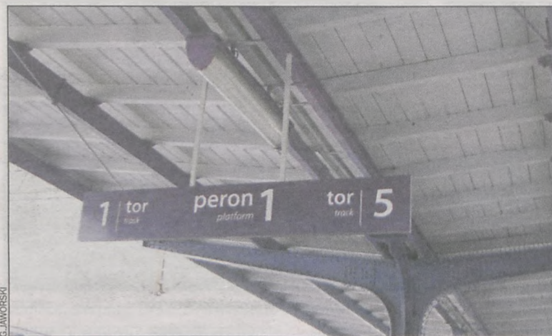
Pod koniec roku odnowiono m.in. zadaszenie nad peronami
