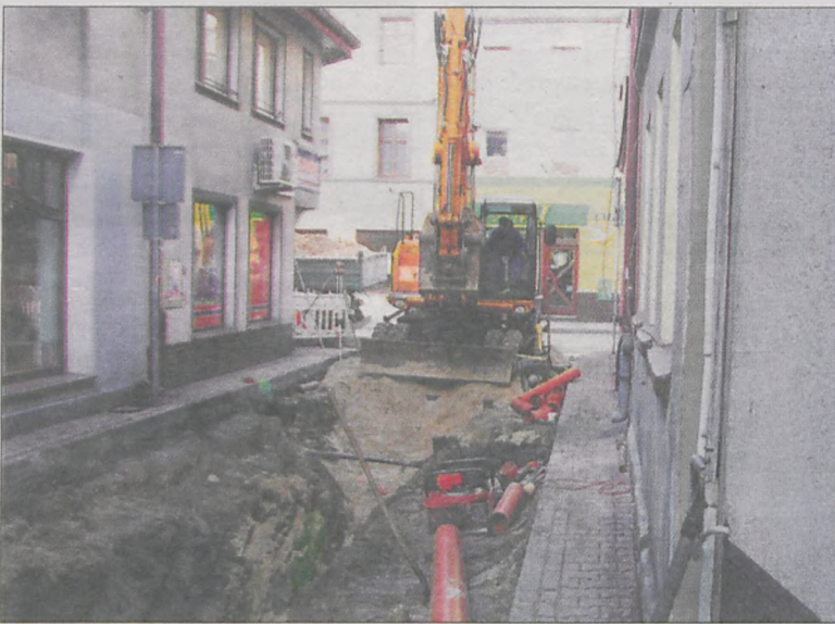
Na Kaszarskiej będzie nowa sieć wodociągowa
