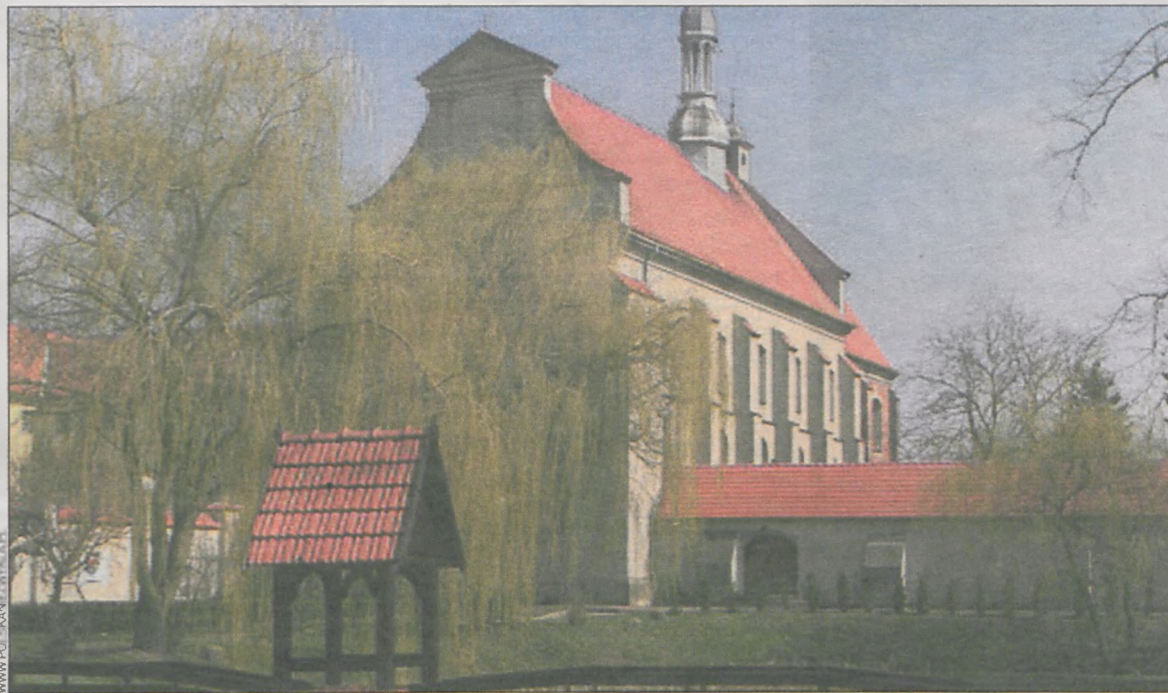
W części zespołu klasztornego w Koźminie Prusacy urządzili więzienie
