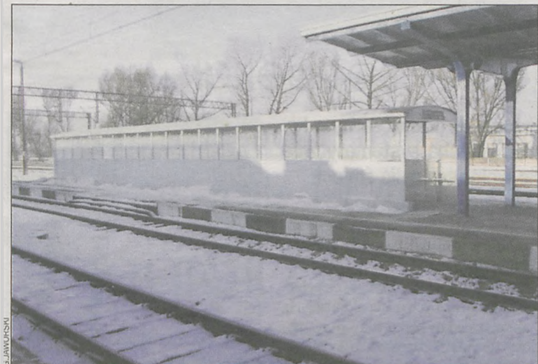
Wejście na perony z przeszklonym zadaszeniem
