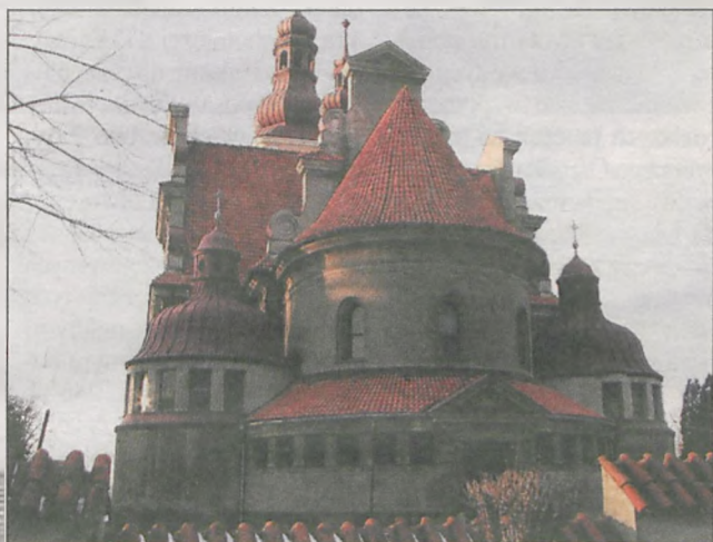
W 2013 r. 25 tys. zł na remont dachu otrzymała parafia w Smolicach
