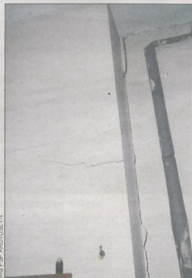
Komin popękał, dlatego ratownicy rozebrali część podbitki dachu
