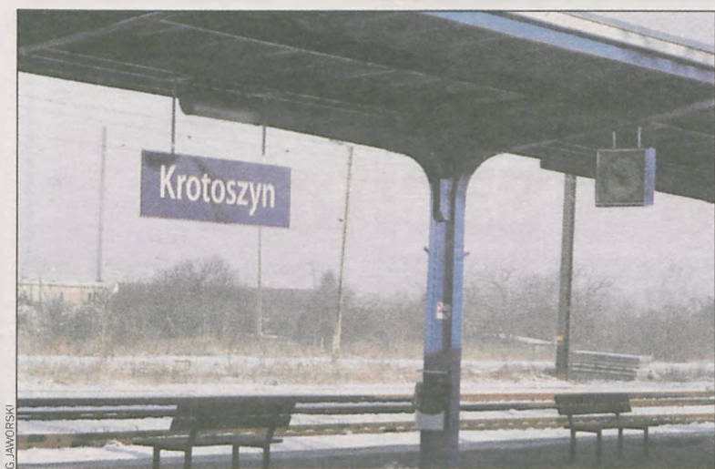
Wiaty na peronie mają nowy dach, są też porządne ławki i kosze
