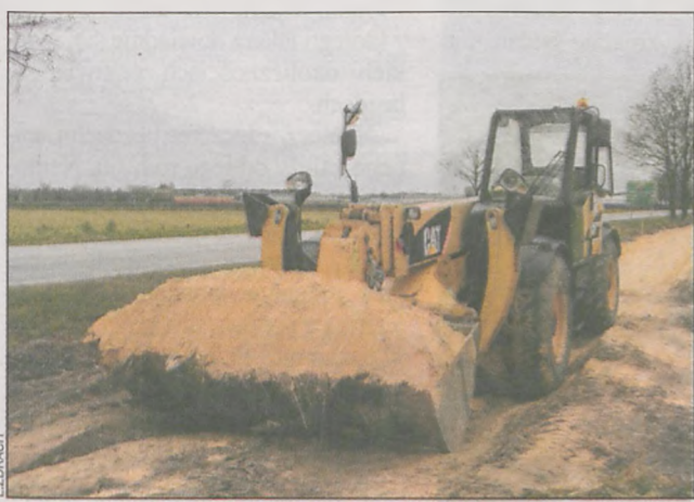
Prace są prowadzone po prawej stronie drogi
