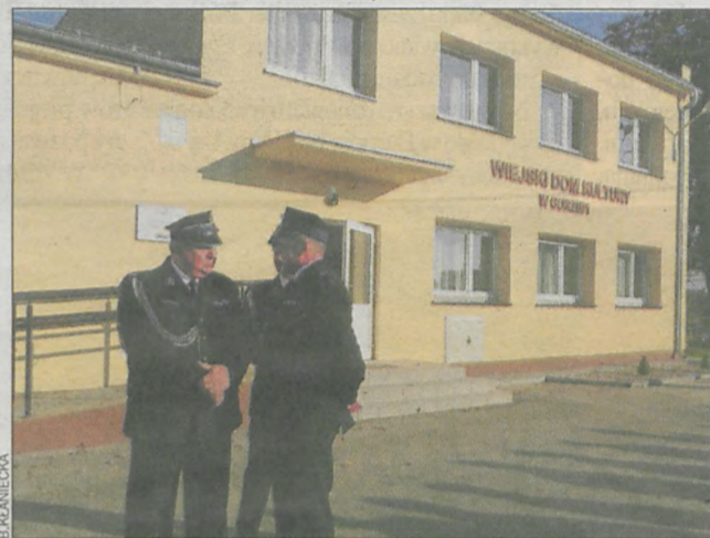
Remont budynku trwał 10 miesięcy
