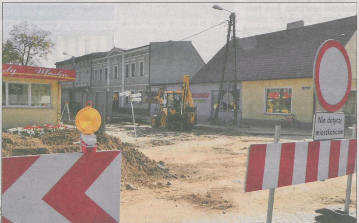
Na al. Klonowicza nadal trwają prace budowlane
