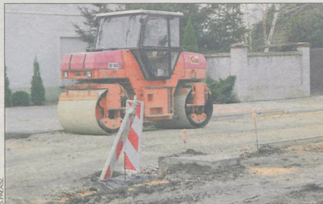
Koszt przebudowy pięciu ulic wyniósł prawie 1,5 mln zł
