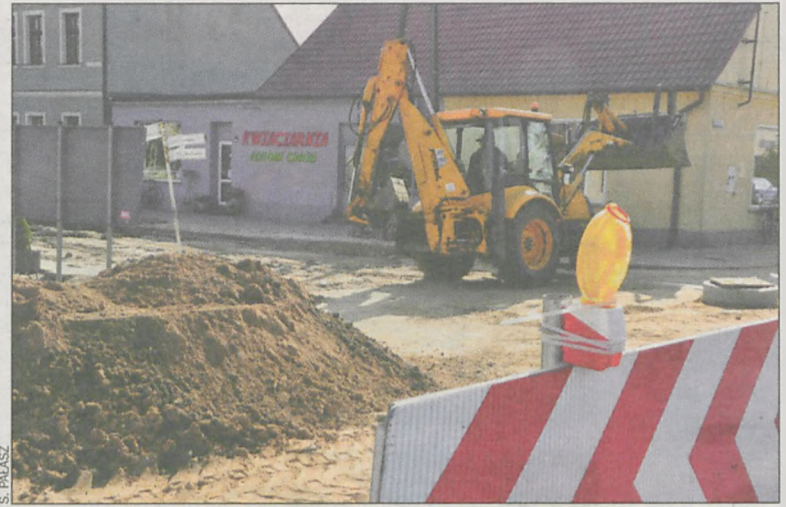
Trwają prace na alei
