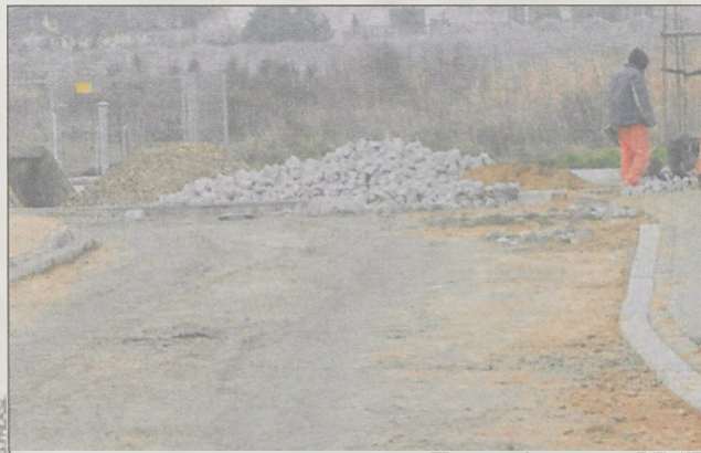
Prace na ul. Grobli. 27 listopada 2014 r.
