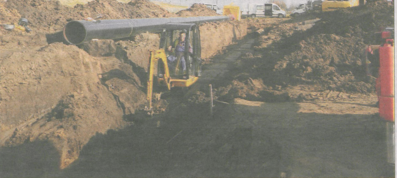
Budowa gazociągu to wielkie przedsięwzięcie
