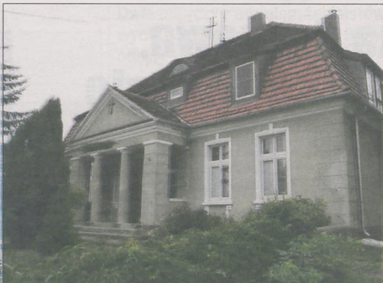
W probostwie trwa remont
