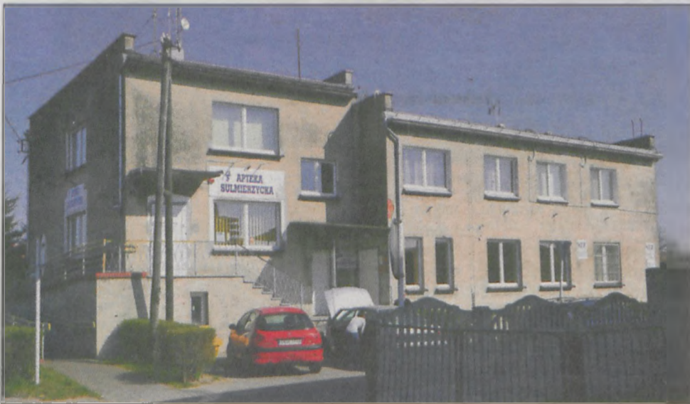
W pierwszej kolejności remontowany będzie podjazd i wózkownia
