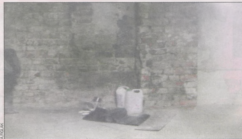
Przez okno widać, że w środku prowadzony jest remont
