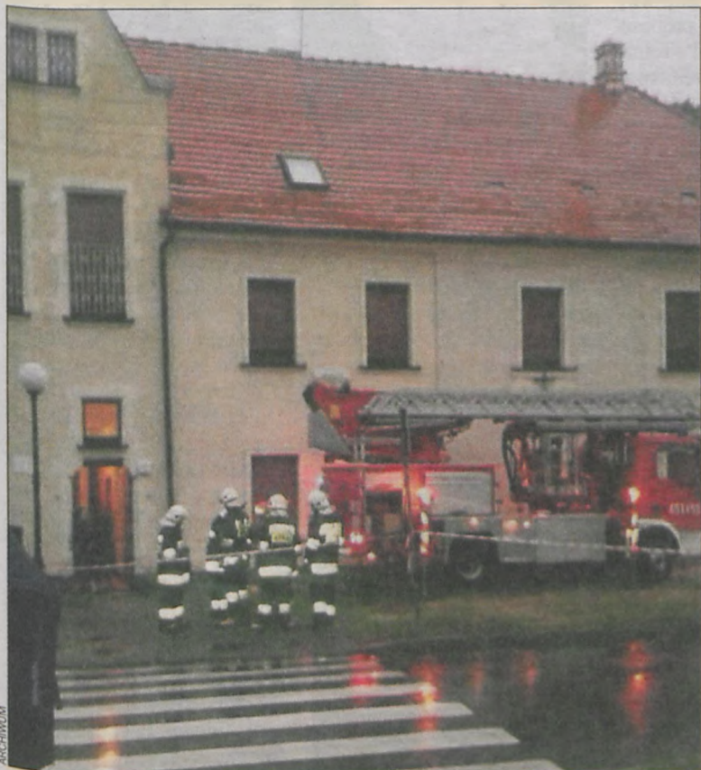
W domu pomocy społecznej w Zdunach naruszony został dach
