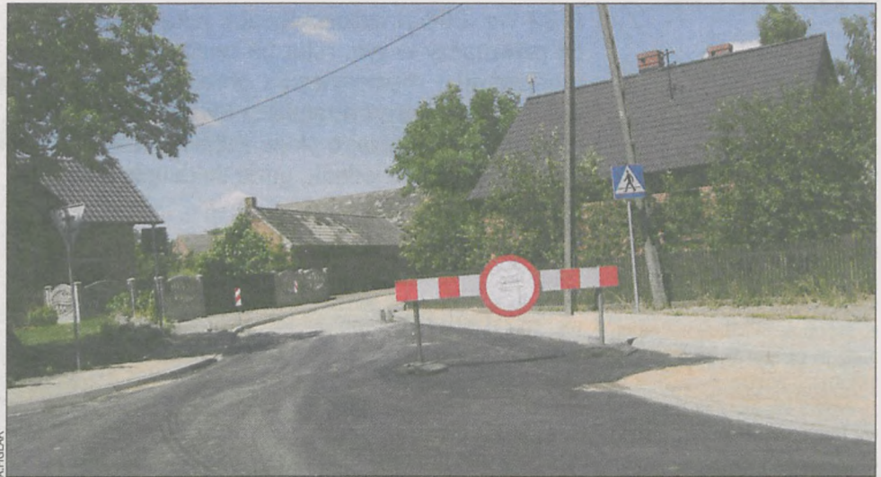
Po dokończeniu przebudowy drogi w Grębowie trasa Rozdrażewek – Różopole będzie najpilniejsza do remontu
