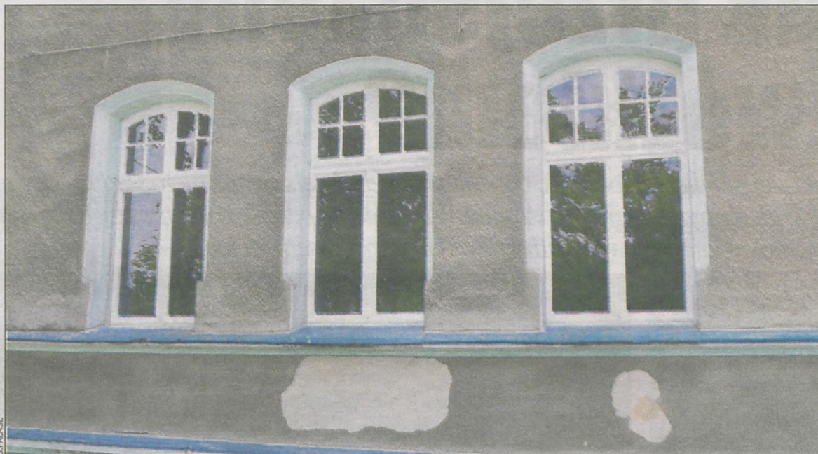
Okna zostały zamontowane w ubiegłym tygodniu
