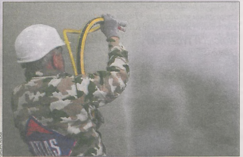
Tynkowanie metodą natryskową skraca czas pracy, jest wydajne i ekonomiczne
