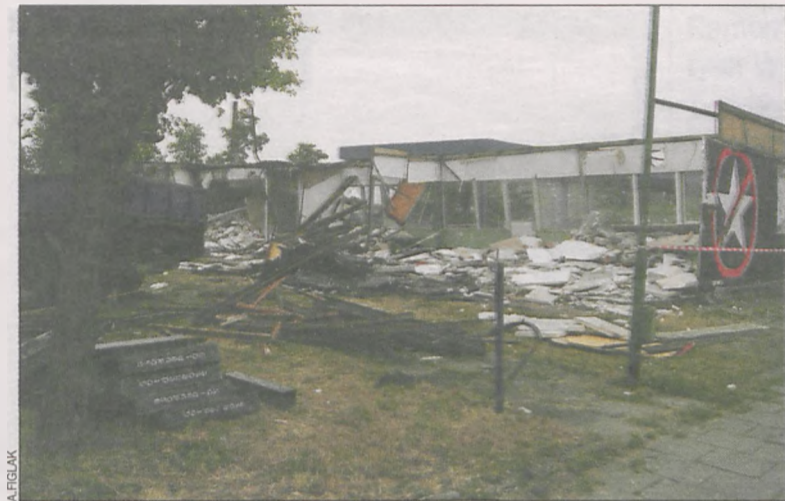
Rozbiórka trwała tylko kilka dni
