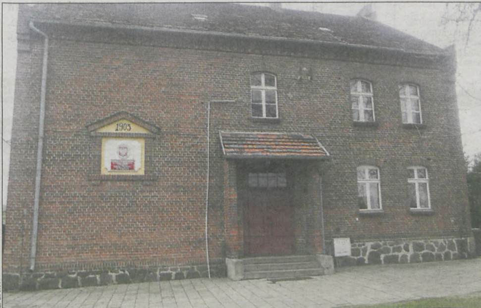
Budynek szkolny we Wziąchowie wybudowany został na początku XX w.
