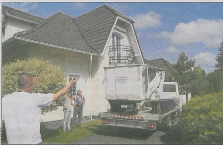
Pracownicy przed czyszczeniem dachu u klienta w Kobylinie
