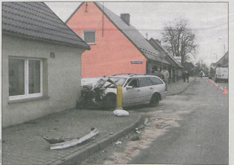
Mercedes wbił się elewację budynku
