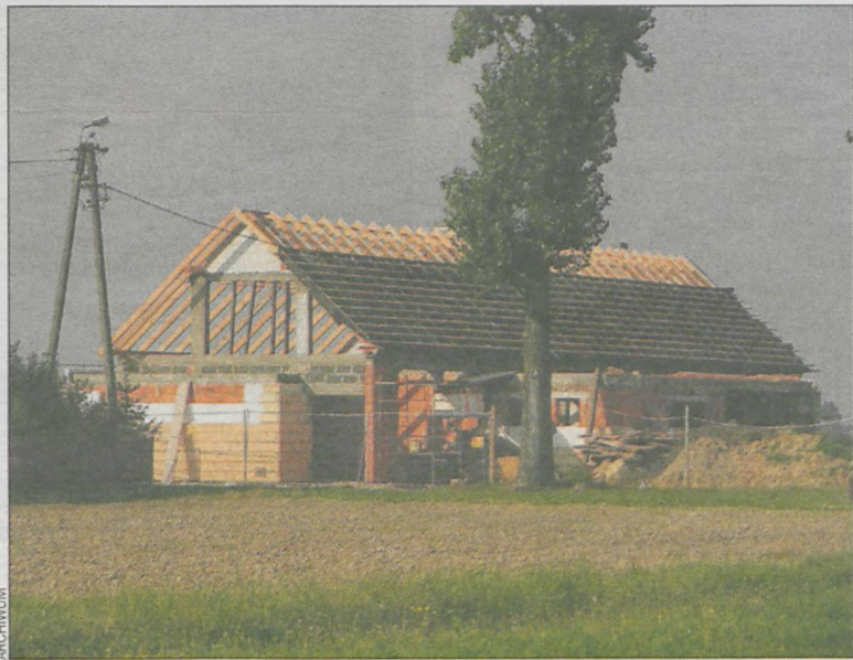
Nowo wybudowana świetlica w Brzozie kosztowała 900 tys. zł
