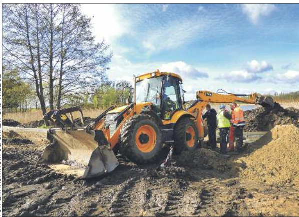
FOT. 2X ARCHIWUM UG CHRZYSKO WIELKIE Początkowe prace budowlane na ul. Jeziornej w Chrzypsku Wielkim...
