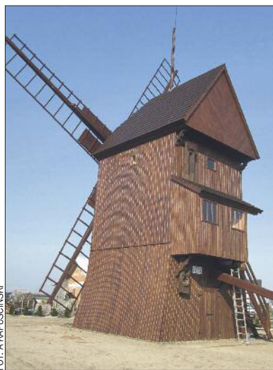
Powiat leszczyński słynie z wiatraków. Niektóre z nich udało się wyremontować dzięki dotacji z PROW.
