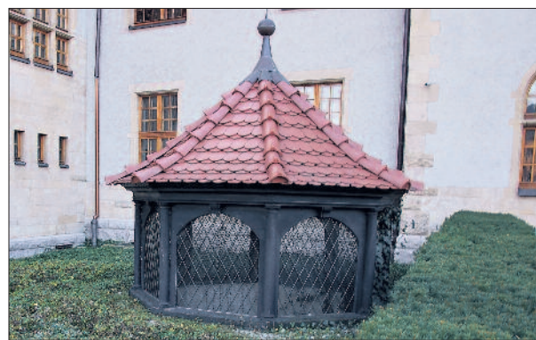
Czerpnia powietrza służącego wentylacji sali, imitująca średniowieczną studnię, przetrwała do dziś.
