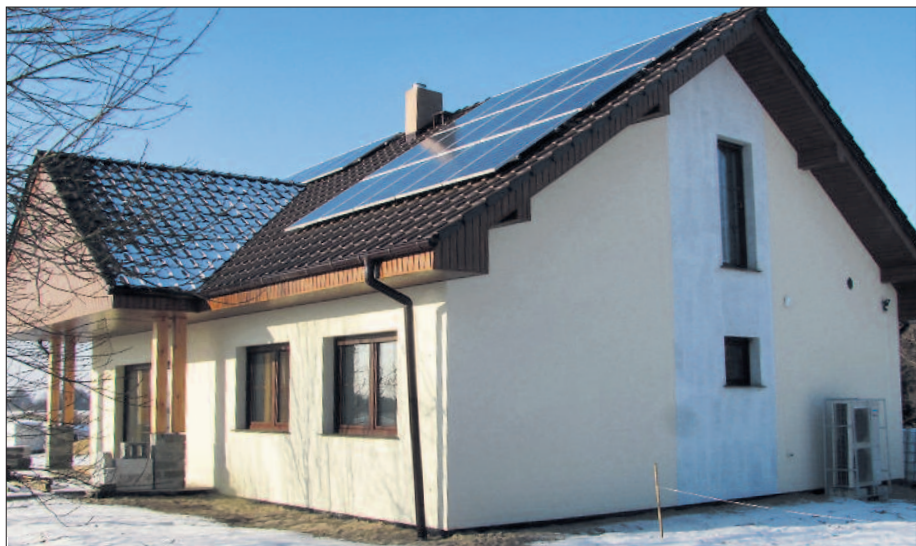
W nowym budownictwie coraz częściej stosuje się ekologiczne ogrzewanie, np. pompę ciepła (z prawej) połączoną z fotowoltaiką (na dachu).
