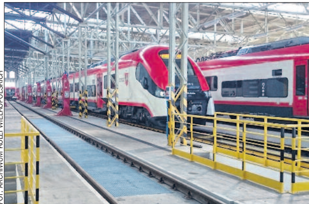
W wyremontowanej hali serwisowane są m.in. „elfy”.
