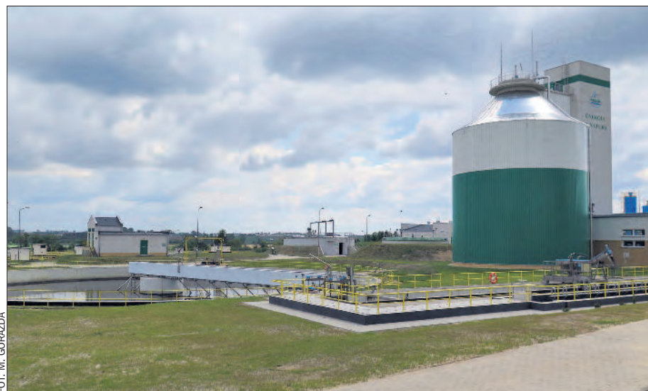
Zmodernizowana oczyszczalnia ścieków w Kucharach.
