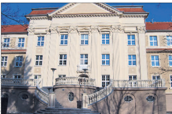
Zabytkowy budynek przeszedł gruntowną termomodernizację, wymieniono w nim dachy i okna, a oddział paliatywny zyskał nową siedzibę.
