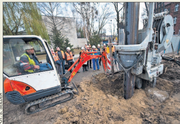
Grudzień 2011 r. – wbijanie pali zabezpieczających wykop pod podziemną część obiektu.
