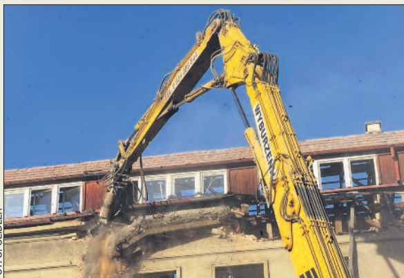
Grudzień 2008 r. – rozbiórka budynku, z którego wcześniej wyprowadził się ODN.
