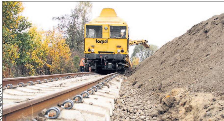
W WRPO 2014+ zaplanowano m.in. przebudowę 4 linii kolejowych. Największym przedsięwzięciem ma być modernizacja trasy z Poznania do Piły, która ma kosztować około 676 mln zł.
